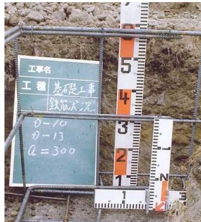
2.基礎部分及び立ち上がり部分の鉄筋組み付け(スーパースペース600).
