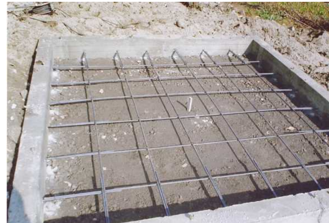
7土間用の鉄筋を背筋
