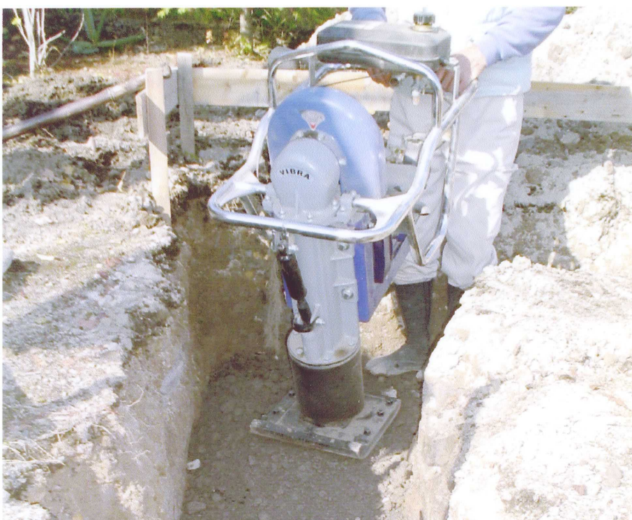
1基礎部分掘削後基礎採石を敷き圧力を掛け採石を締め固める。
