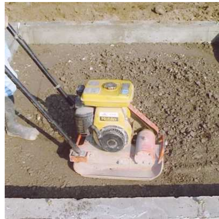
6.型枠取り外し後土を埋め戻し天圧を掛けて締め固める
