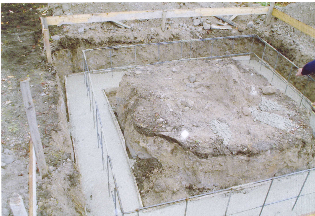
3ベース部分のコンクリート打ち
