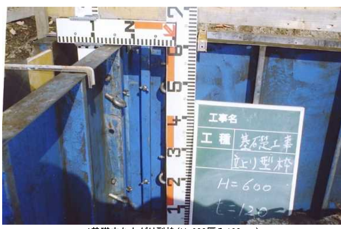
4基礎立ち上がり型枠(H=600厚み120mm)
