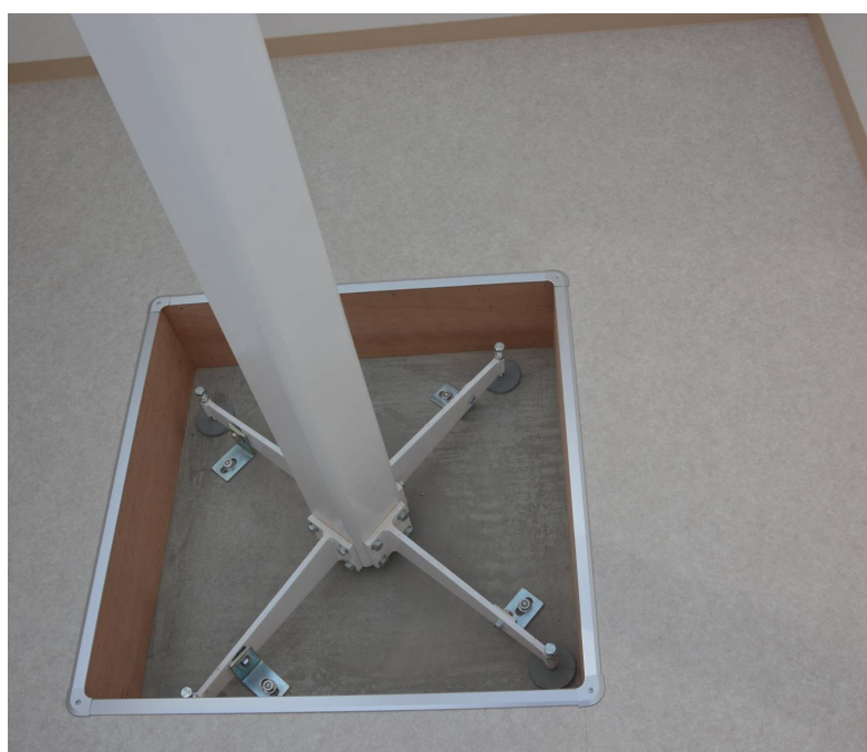
ピラー埋め込み状況
